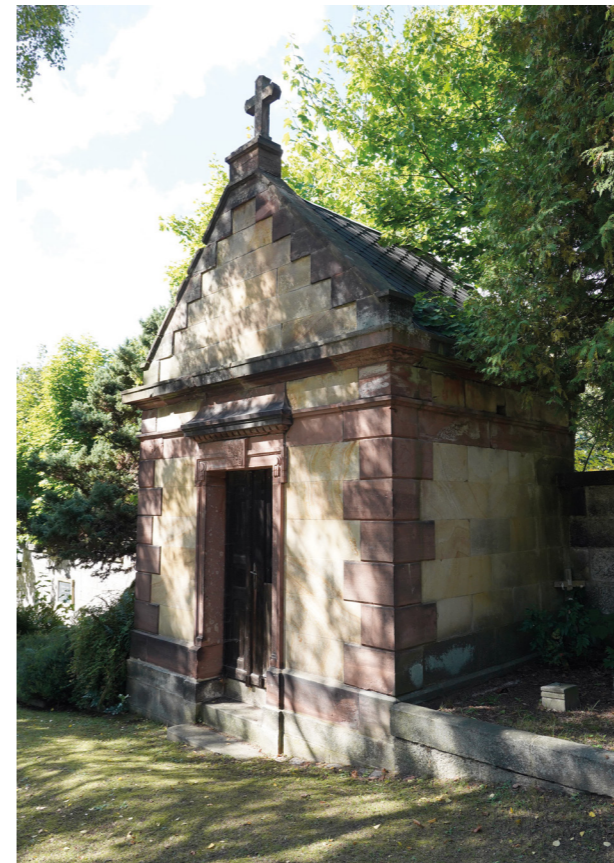
Obr. 3.1.13a, b Jablonec nad Nisou (okres Jablonec nad Nisou). Hřbitovní kaple (umrlčí komora) kombinuje kvádrové zdivo ze světlé okrových pískovců a načervenalých arkóz. Dole: detail kamenného zdiva.
