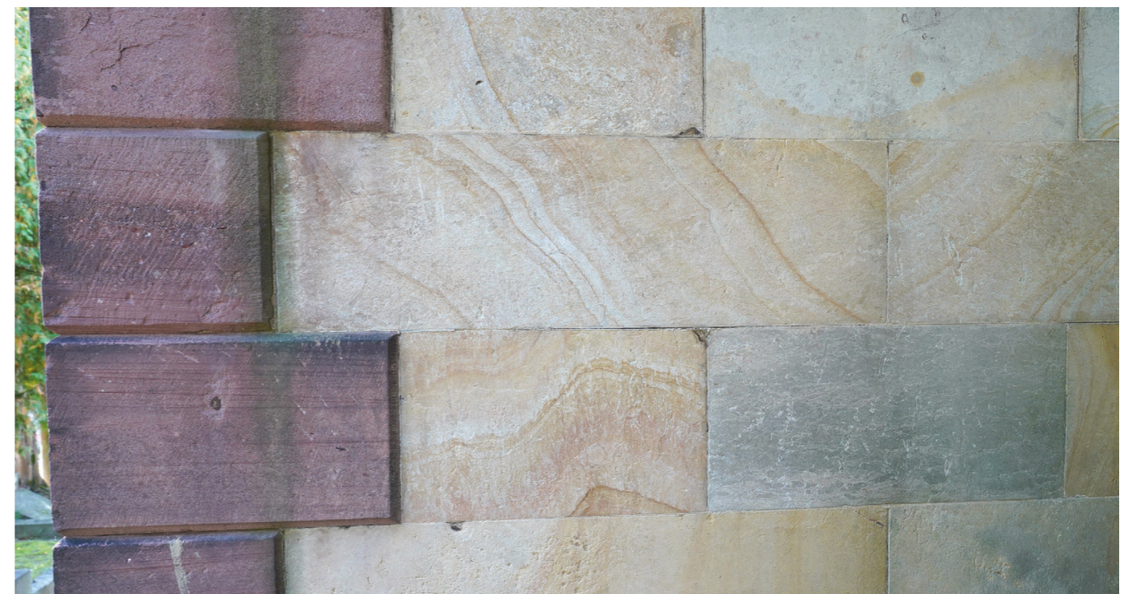
Obr. 3.1.13a, b Jablonec nad Nisou (okres Jablonec nad Nisou). Hřbitovní kaple (umrlčí komora) kombinuje kvádrové zdivo ze světlé okrových pískovců a načervenalých arkóz. Dole: detail kamenného zdiva.
