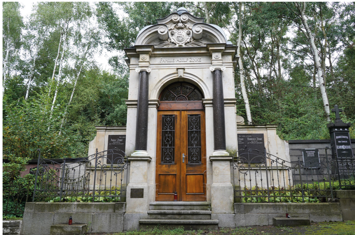
Obr. 3.1.12 Arnultovice u Nového Boru (okres Česká Lípa). Monumentální hrobka ve stylu neobaroka kombinuje světlé labské pískovce s tmavým larvikitem použitým na dřívky moutentálních sloupů a nápisové desky.
