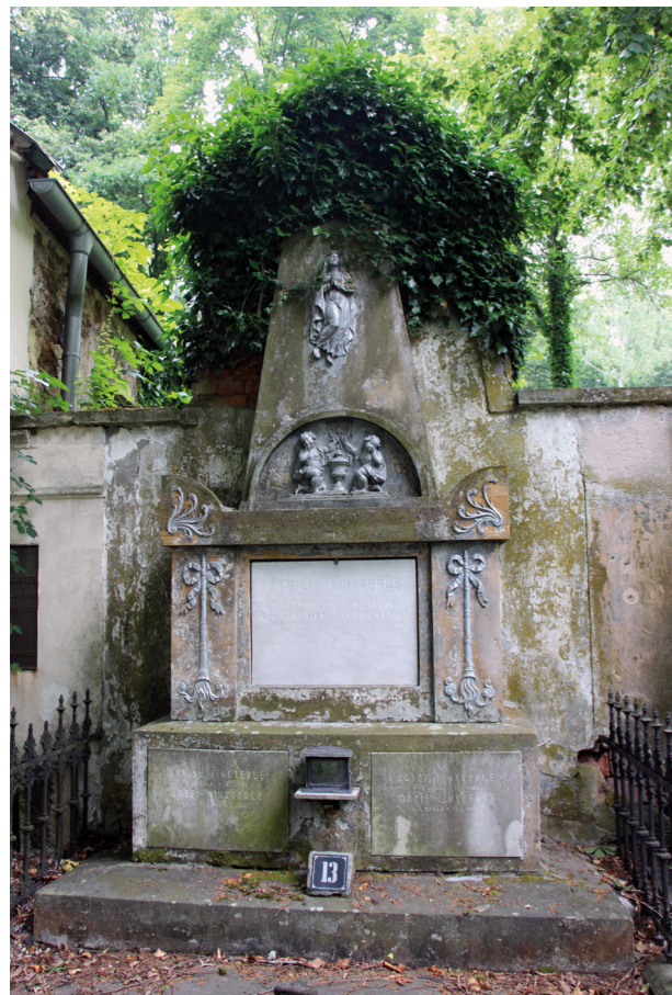
OBR 16 Kamenný náhrobek s amatérskými přetěry stříbřenkou. Hřbitov v Moravské Třebové (okres Svitavy). Foto: ZA.
