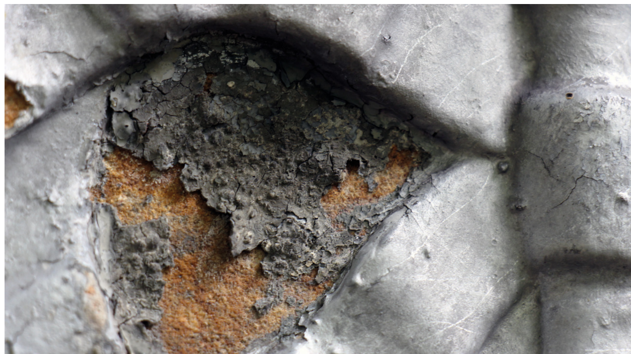
OBR 1.8.17 (Detail OBR 1.8.16) – sulfatizovaná povrchová úprava. Hřbitov v Moravské Třebové (okres Svitavy). Foto: ZA.
